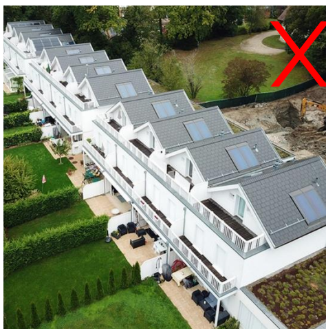
Type d'alignement bâti continu de plus de 3 constructions interdit
