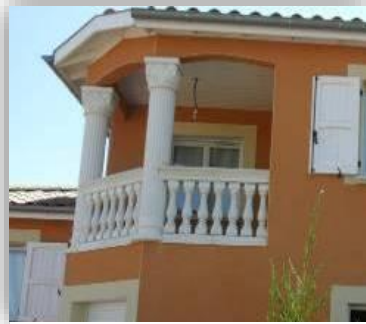
Type de balustres interdites
